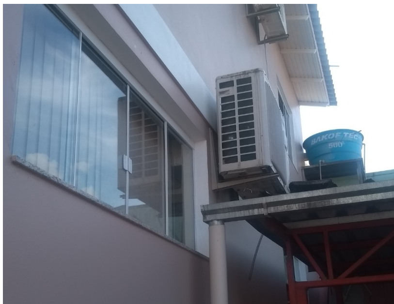
Foto 1 – Situação de instalação da unidade evaporadora, item 3.1.1
